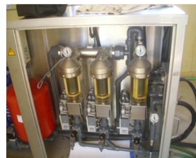
Figure 54: Filtre 100µm et deux filtres 25µm
