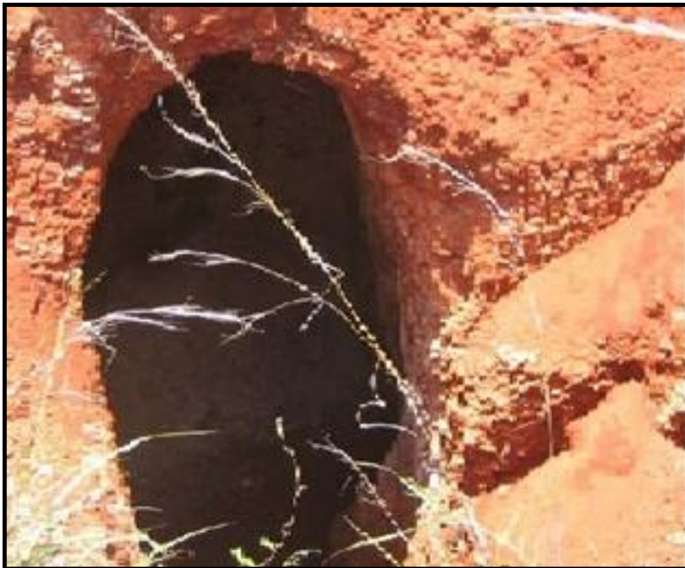
Photo 23 : - Dégradation du site d'exploitation minière à Bemahatazana
