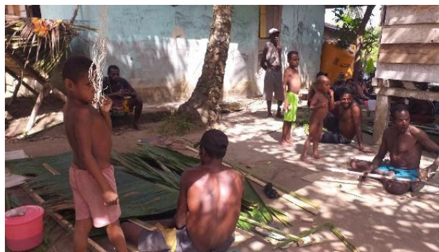
Gambar 15. Proses Pembuatan Atap
