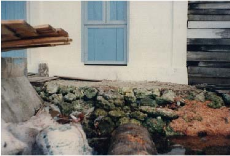
Gambar 34. Skeleton karang massive yang digunakan masyarakat untuk dasar/pondasi rumah di Tapak Tuan, Propinsi Aceh. Tanda panah penunjuk skeleton koloni karang yang digunakan untuk dasar bangunan rumah (Foto oleh Thamrin)
