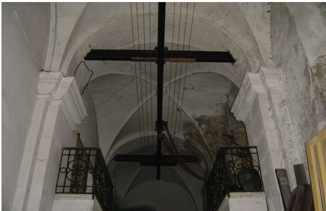
Au 1 er étage : les voûtes d'arêtes ; les chapiteaux toscans ; les arcs doubleaux et formerets
