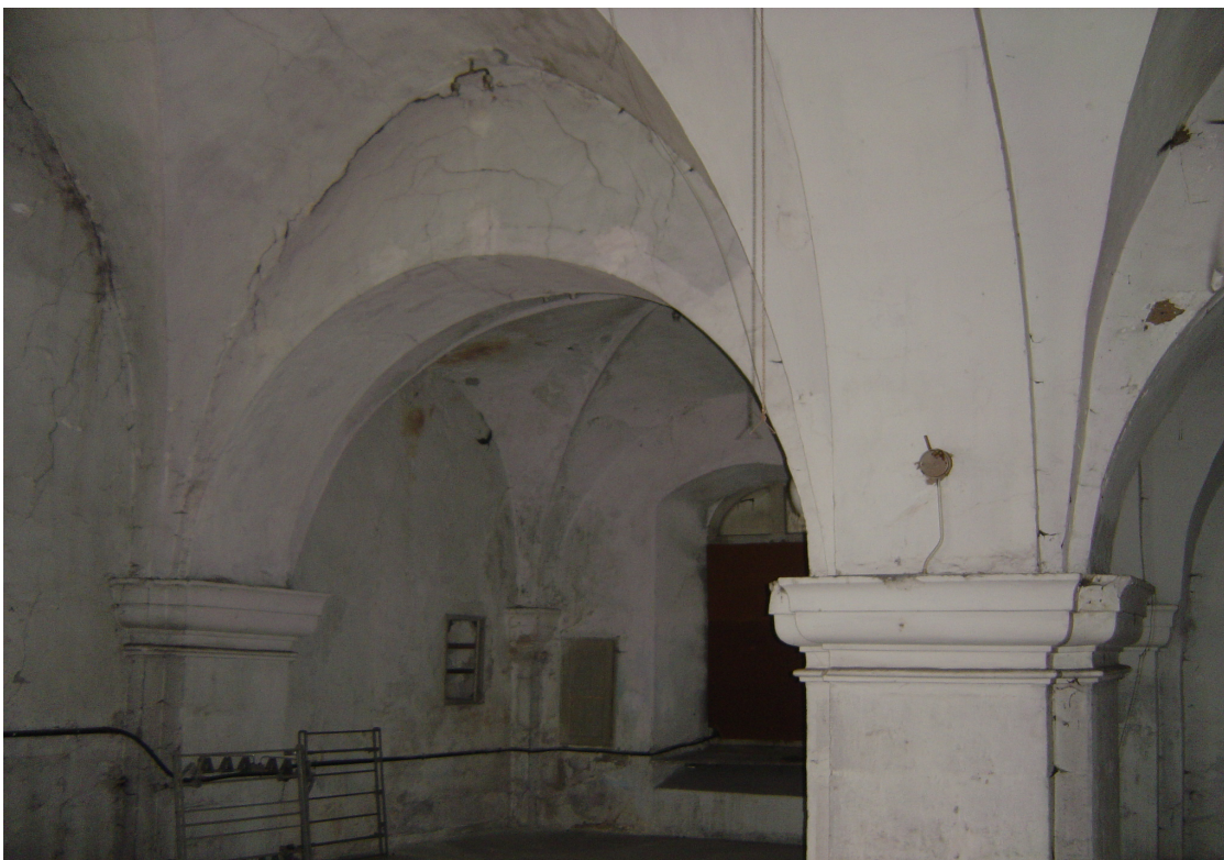
Au 1 er étage : les voûtes d'arêtes ; les chapiteaux toscans ; les arcs doubleaux et formerets
