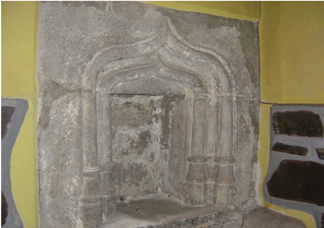
Arc en accolade (au rez-de-chaussée) : sans doute un reste de la construction antérieure
