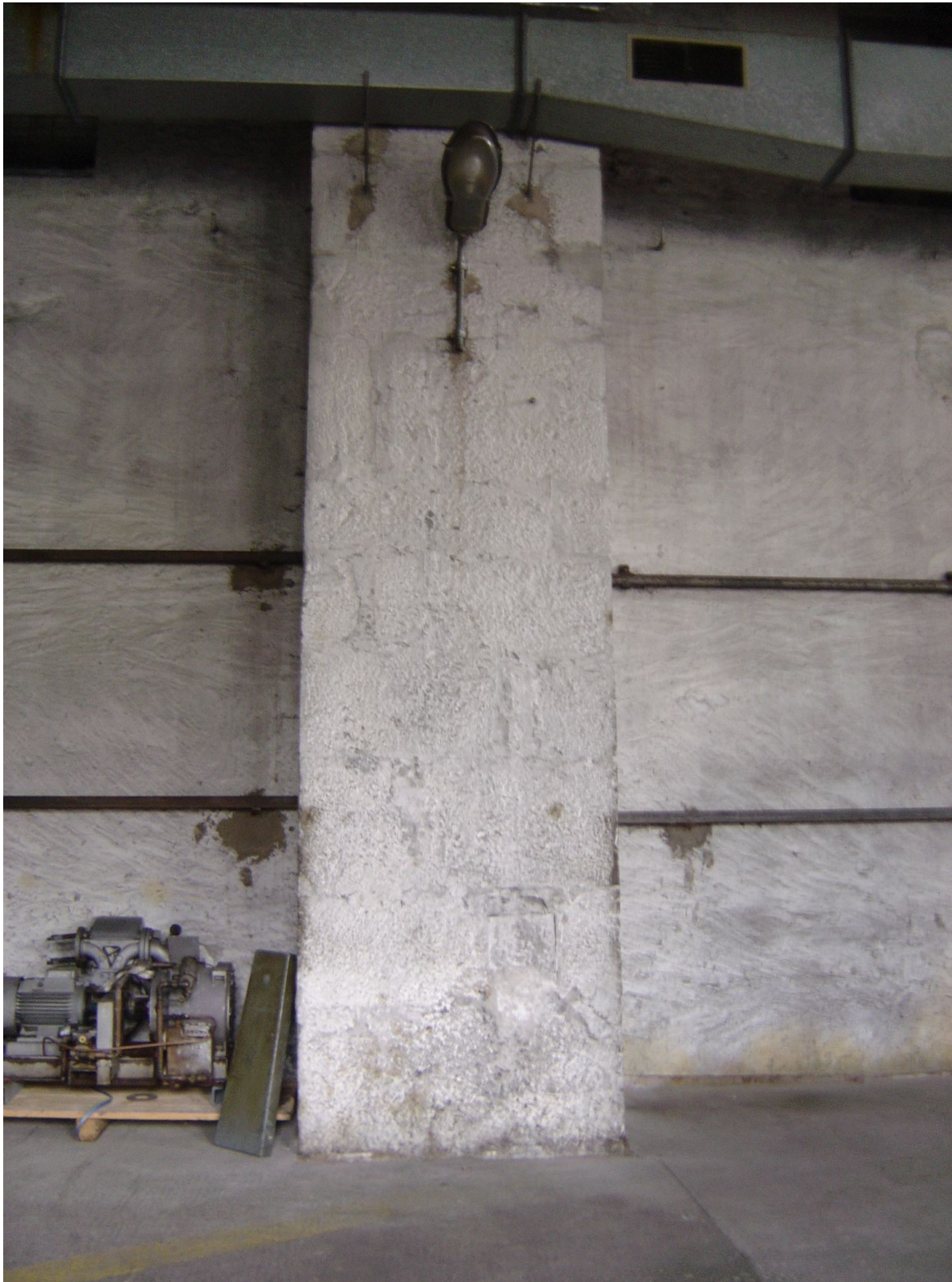
contrefort extérieur aujourd'hui enserré dans une construction nouvelle
