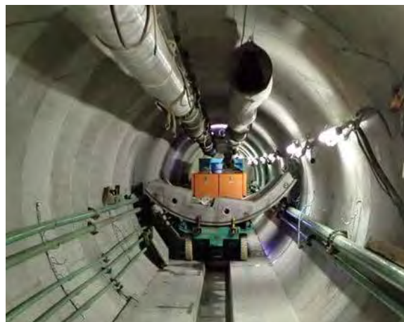
コンパクトシールド工法で使用する密閉型シールド機とセグメント搬送作業の様子
