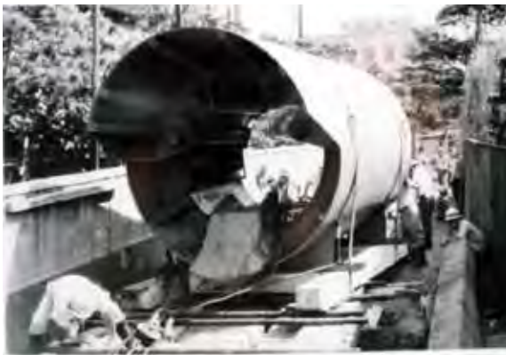
石神井川下幹線工事で使用した開放型シールド機と作業の様子
