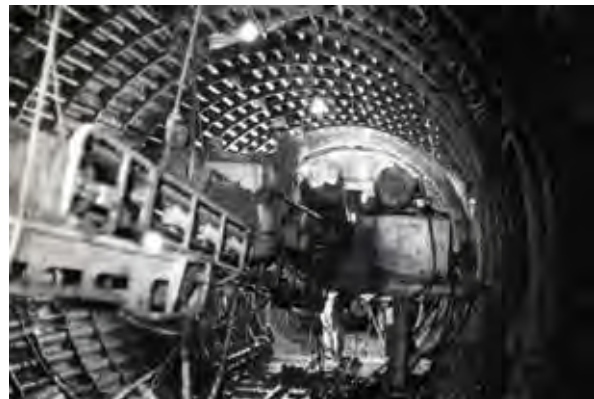
石神井川下幹線工事で使用した開放型シールド機と作業の様子
