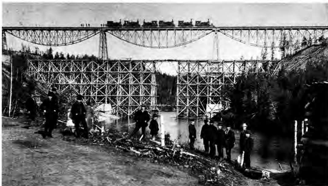
Den första Öreälvsbron provas sedan den färdigbyggts 1891. Vid provning belastades broarna med så stor vikt som möjligt, i detta fallet med lokomotiv. Träställningen under bron användes när mellanpelarna och spannen byggdes, efter godkänd provning revs de.
