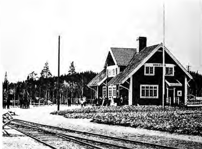
Järnvägsstationen i Dorotea. Stationshusen längs Inlandsbanan byggdes av trä och man eftersträvade en viss regional prägel.
