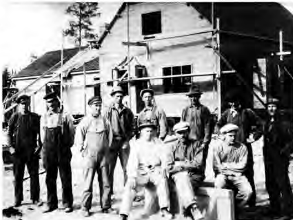
Fotografen Birger Lekberg från Dalarna har efterlämnat många bilder av arbetet med Inlandsbanan under 1920-talet. Lekberg var en tid bosatt i Sorsele. Här har han förevisat en grupp arbetare som står framför Sandsele stationshus. Martin Lundgren själv står näst längst till höger i bild. Hans pappa, Emanuel ”Manne” Lundgren som var byggmästare, står näst längst till vänster, intill en annan av sina söner, Gustav.
