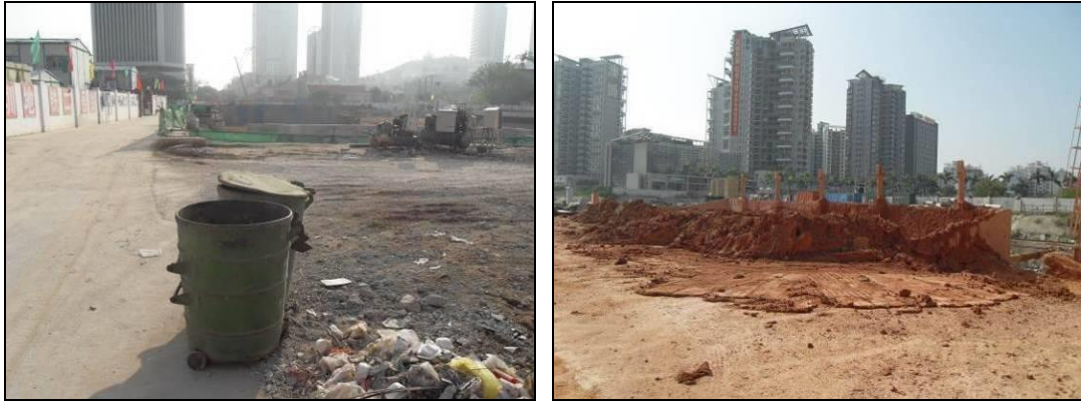
图 11.1-4 施工场地生活垃圾收集和弃土转运
