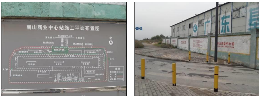
图 11.1-1 施工场地布置及周边围挡
