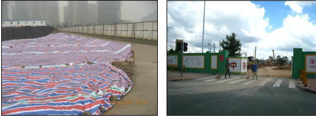
图 11.5-2 弃土覆盖和路面清扫
