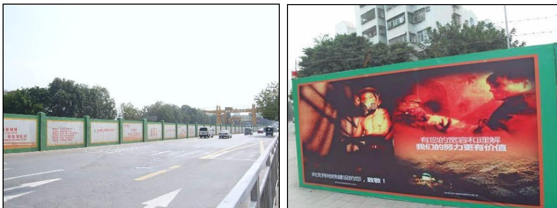
图 11.1-5 施工场地周边围挡及美化
