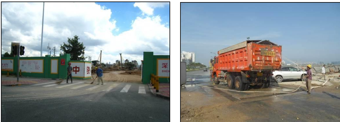
图 11.1-3 施工场地清扫和车辆清洗
