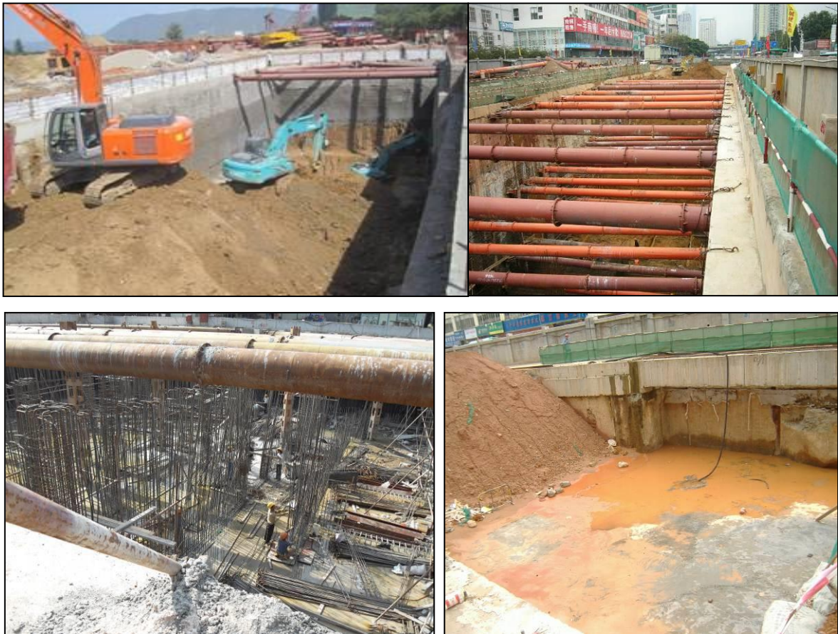
图 2.2-5 车站结构施工现场照片
