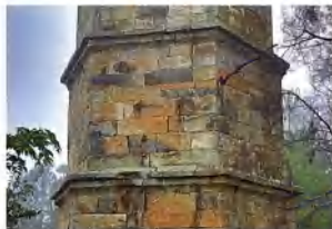
文笔塔石砌塔基
