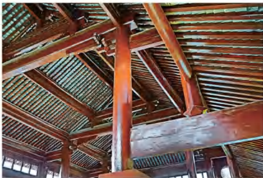
大成殿拾梁架结构
