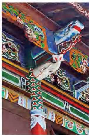
大殿檐下的木雕彩绘梁柱
