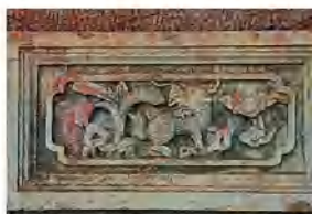
大成殿山墙石壁堵基
