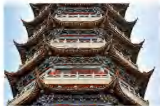
文塔塔塔基结构
