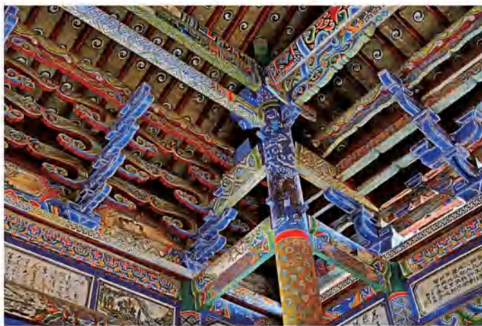
大成殿梁柱结构
