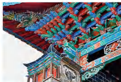
大成殿斗拱与山墙角
