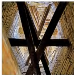
塔心安装的十字形木构架
