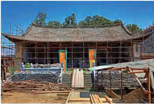
维修中的江川文庙大成殿
