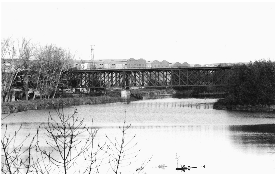
FIGURA 7. Puente del Pradillo. Vista parcial.
