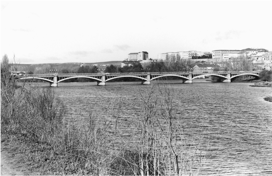
FIGURA 11. Puente de Enrique Estevan. Vista general. Años 1898-1913.
