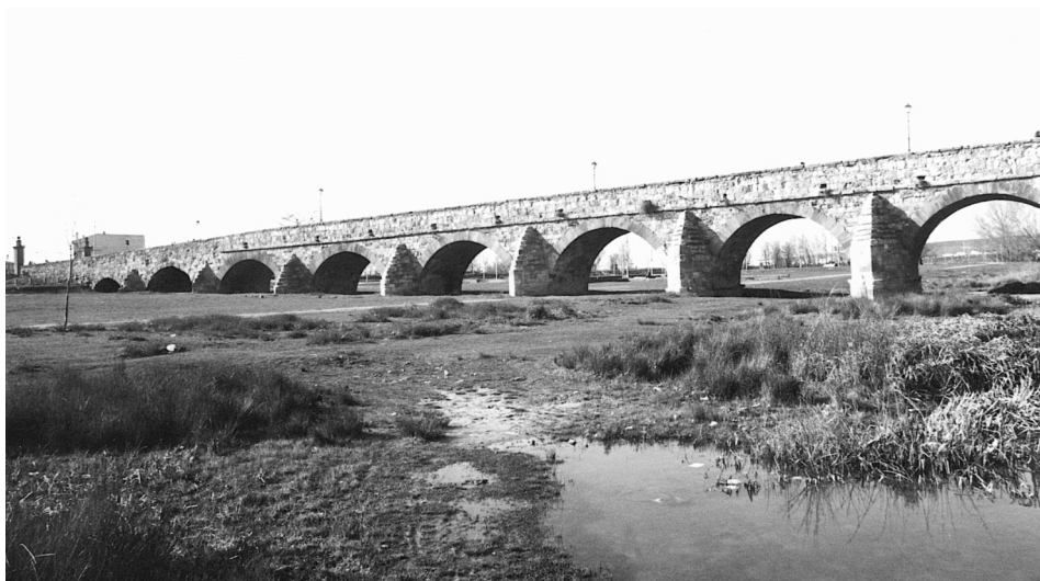
FIGURA 1. Puente Romano. Vista parcial hacia el sur. Reconstrucción del siglo xvii. Años 1674-1677.
