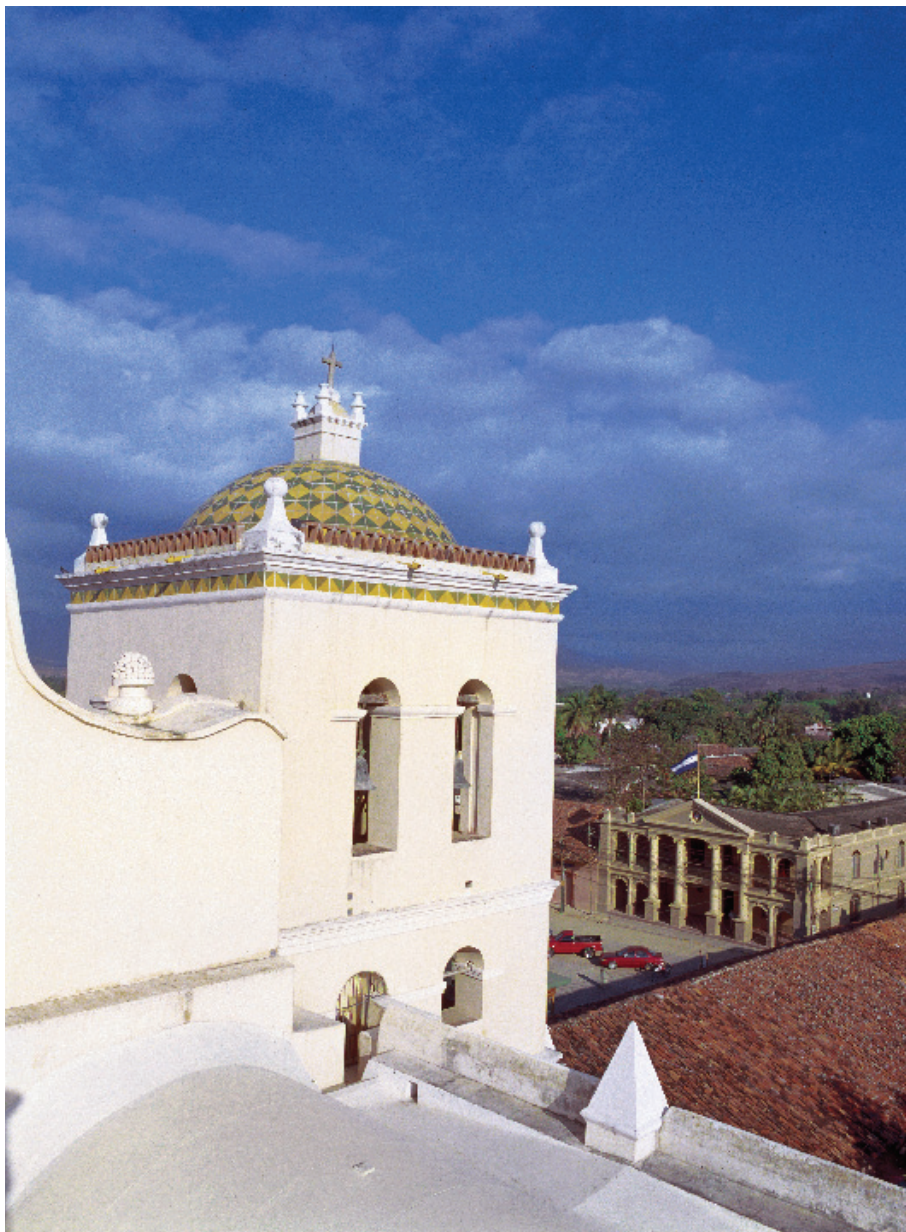
1. Palacio Municipal de Comayagua.
