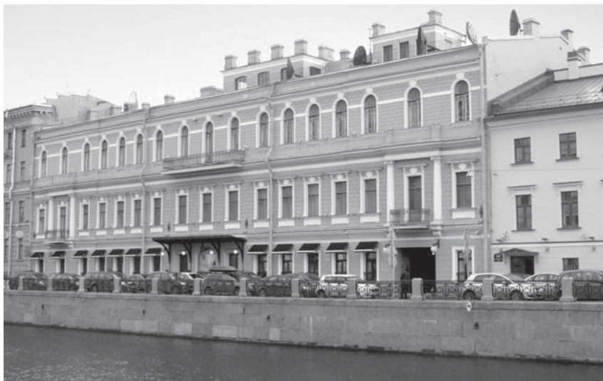
Здание Главного правления РАК в Санкт-Петербурге. Мойка, 72
