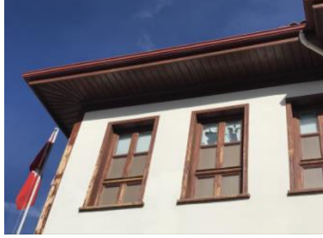
Şekil 37. Gazi Osman Paşa Konağı Çatı Saçağı Görünümü (Talu, 2018)
