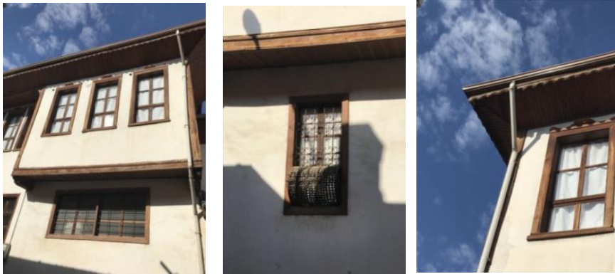
Şekil 45. Cevdet Erek Konutu Ön Cephe Pencereleri ve Çatı Saçağı (Talu, 2018)
