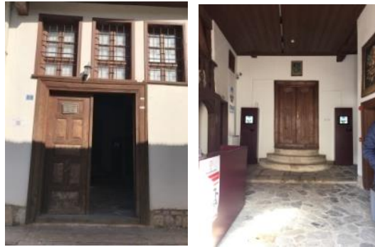
Şekil 26. Gazi Osman Paşa Konağı Kapı ve Taşlık Görünümü (Talu, 2018)
