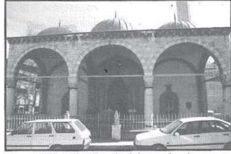
Zile Ulu Cami giriş cephesi
