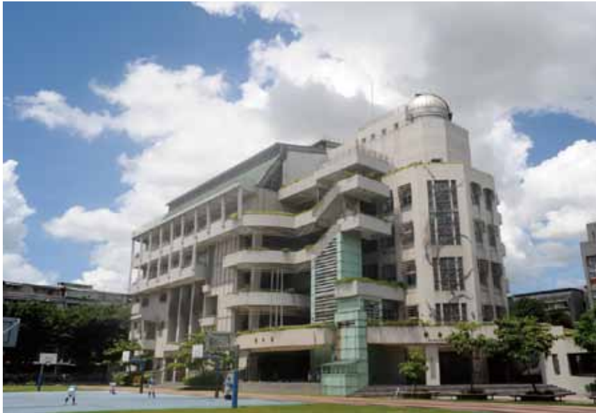
位於雙中綜合大樓頂端的天文臺圓頂
