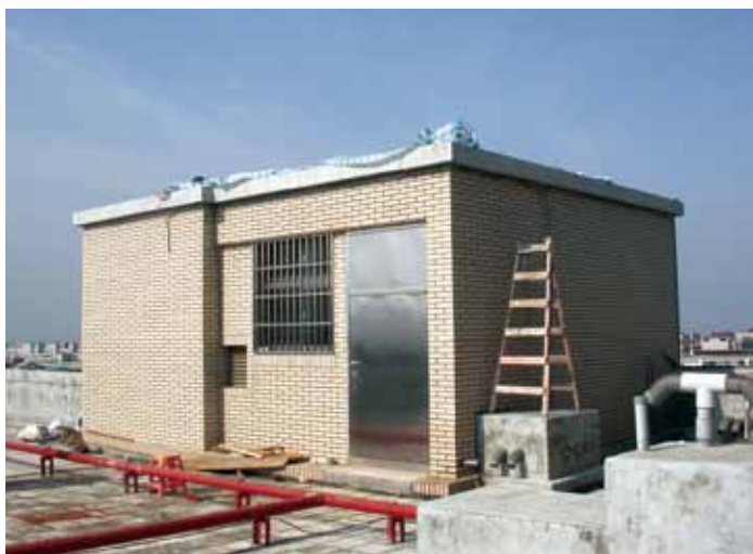
大里高中天文臺捨棄圓頂，而改用雙層隔熱不銹鋼觀測平頂
