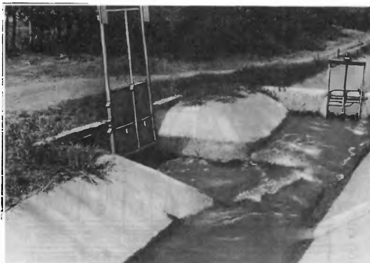
Рисунок 4.4 – Вододелитель с регулятором и подпорным сооружением
