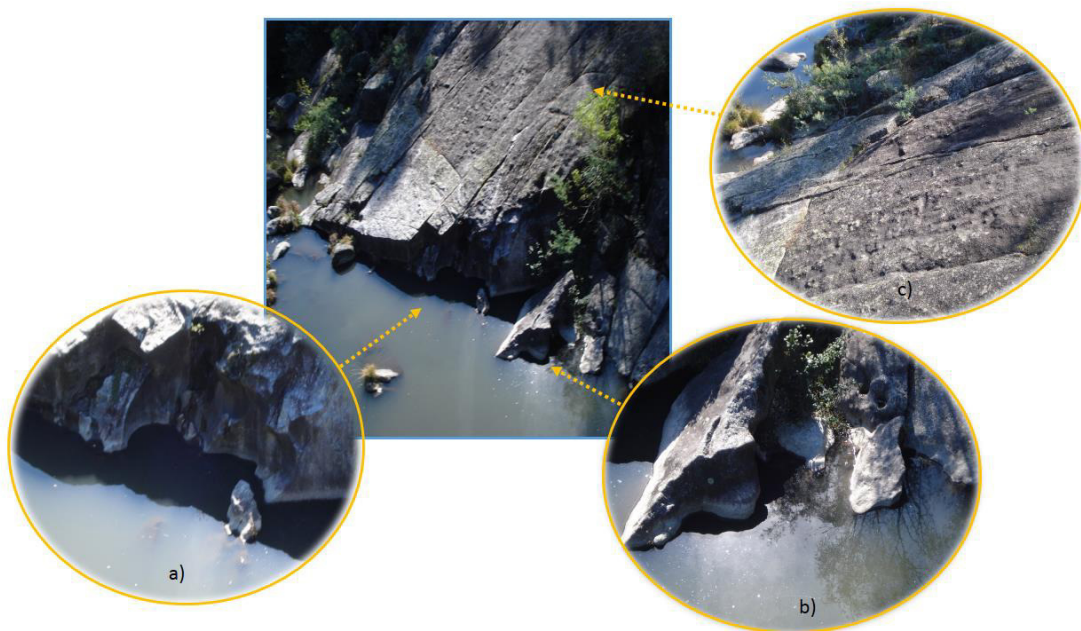
Figura 22. Marcas de erosão observadas no a montante da Ponte de Parada.
