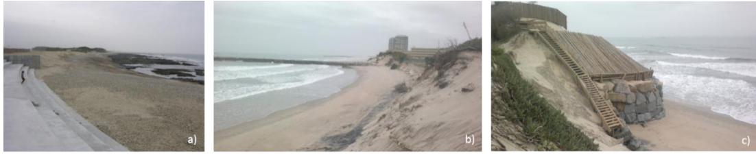
Figura 6. Zonas de risco de erosão costeira; a) Praia de S. Bartolomeu do Mar, b e c) Praia Sul de Ofir (fotografias da autora tiradas em janeiro de 2015).
