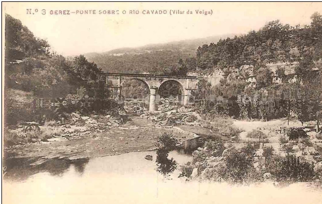
Figura 20. Ponte sobre o rio Cávado em Vilar de Veiga, atualmente submersa pela construção da Barragem da Caniçada (Ponte sobre o rio Cávado (Vilar de Veiga), 2010).
