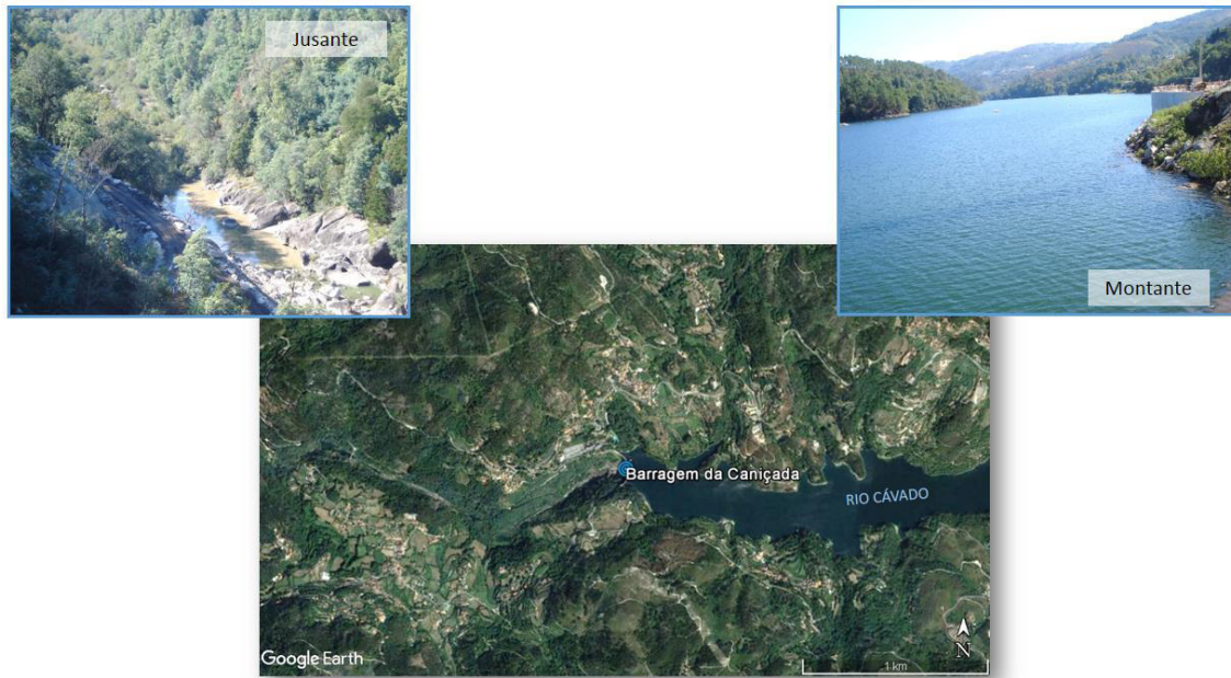
Figura 18. Barragem da Caniçada, Terras de Bouro. Fotos tiradas em 2016. Imagem de satélite modificada do Google Earth.
