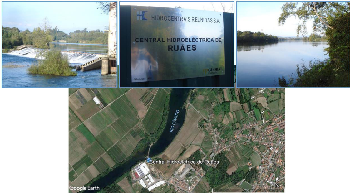
Figura 38. Central Hidroeléctrica de Ruães, Braga. Fotos tiradas em 2016. Imagem de satélite in Google Earth.
