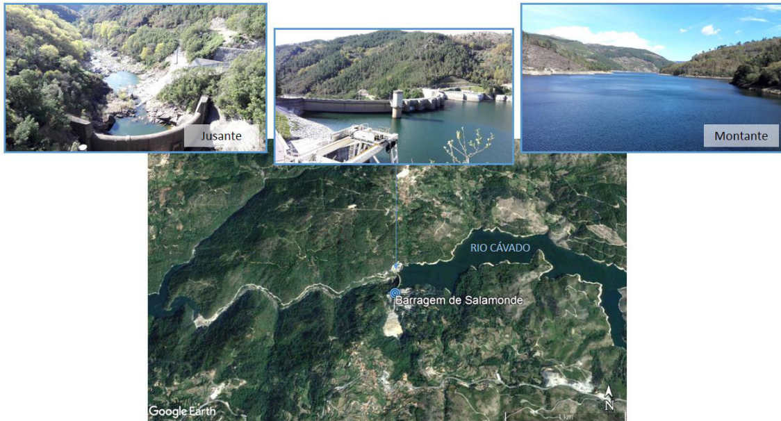
Figura 17. Barragem de Salamonde, Vieira do Minho. Fotos tiradas em 2016. Imagem de satélite modificada do Google Earth.
