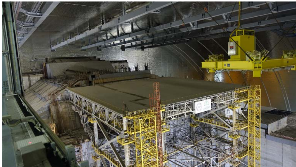
Abb. 15.3 NSC mit dem Sarkophag und dem Hauptkransystems während des integralen 72-h-Testbetriebs (Quelle: Präsentation des KKW Tschernobyl, Juni 2019)
