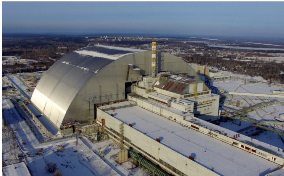
Abb. 15.1 NSC nach der Positionierung und Verschiebung. Blick aus östlicher Richtung (Quelle: Präsentation des KKW Tschernobyl, Mai 2017)
