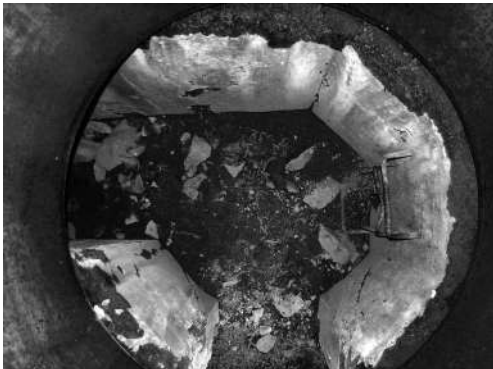
Фото 5. Приміщення для спостерігача в спостережному пункті Керешмезького вузла оборони.
