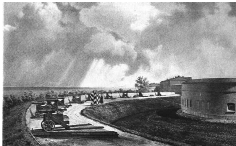
Рис. 7. Кронштадт, укрепления Северной стороны. Карронады и пушки на высоких крепостных лафетах, установленные на настильных платформах, оборудованных поворотным брусом (рисунок из книги А. А. Раздолгин, Ю. А. Скориков «Кронштадтская крепость». – Л.: Стройиздат, 1988).
