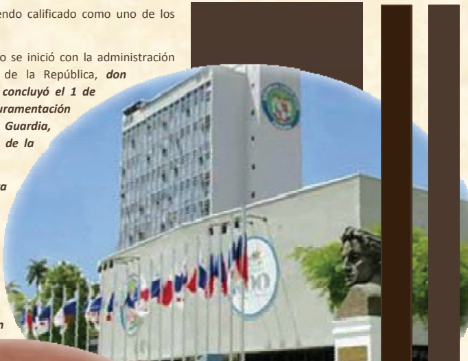
Palacio Justo Arosemena 2006, año del Centenario del Órgano Legislativo y aprobación de la Ley 33 de 22 de agosto de 2006, que declara monumento nacional, al Palacio Justo Arosemena. Fungió como Presidente el Honorable Diputado Elías Castillo.
