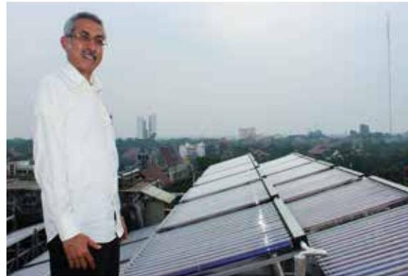
● **Solar Thermal Cooling System** merupakan hasil kerjasama Lab Saito Waseda University dan Kawasaki Thermal Engineering (KTE), berfungsi untuk mereduksi CO2 dan polusi udara dengan menggunakan Absorption Chiller yang menjadikan sumber panas sebagai energi utamanya dari Energi Matahari melalui Solar Thermal Collector. Solar Thermal Cooling System ini ditempatkan di atap gedung MRC.
