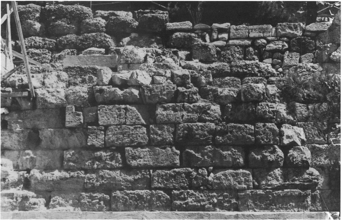
Εικ. 45. Στοά Ευμένη. Υπολείμματα της εξωτερικής όψης του αφιδωτού τοίχου κατά χώραν και συμπληρώσεις που ανήκουν στο υστερορωμαϊκό τείχος.
