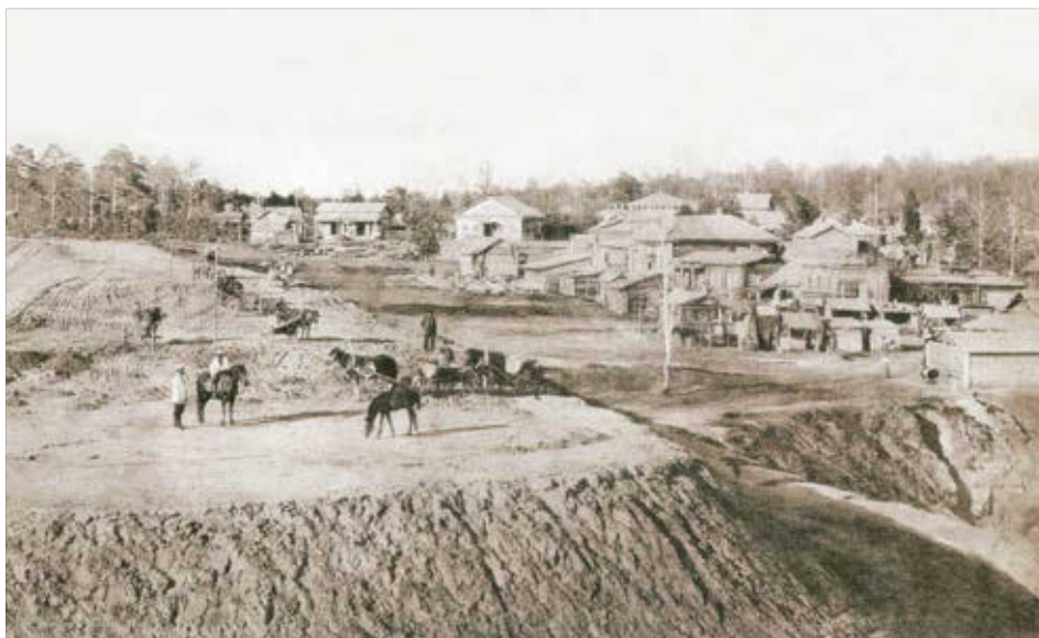
25. Работы по строительству железной дороги и моста у села Большое Кривощеково (фото 1893–1894 гг.)
