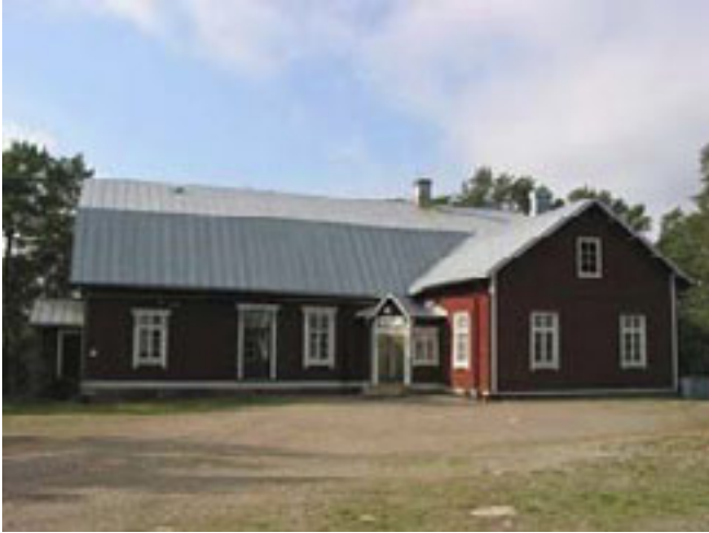
Seuratalo sijaitsee kylän korkeimmalla kohdalla harjun päällä.
