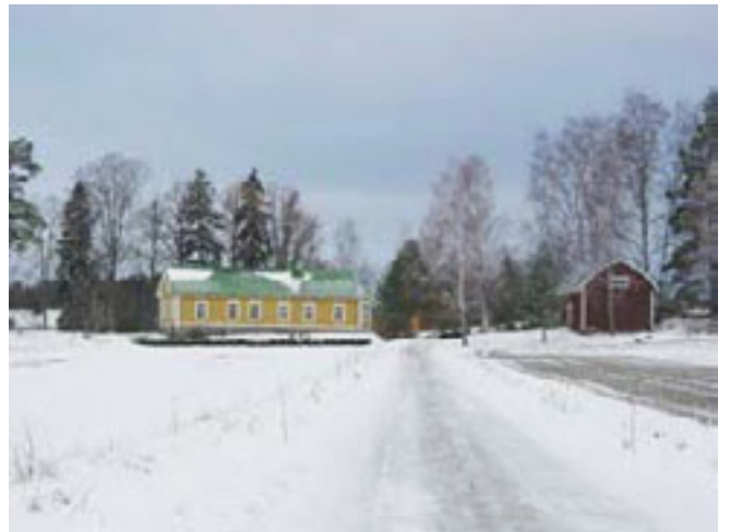
1840-luvulla rakennettua päärakennusta on laajennettu myöhemmin.
