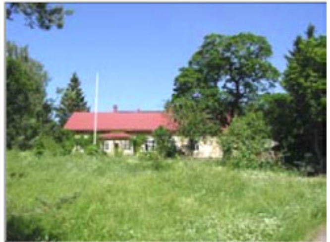
Pappilan päärakennus. Julkisivujen uusrenessanssi- ja neoklassisistiset piirteet ovat peräisin 1880-luvun muutostöistä.
