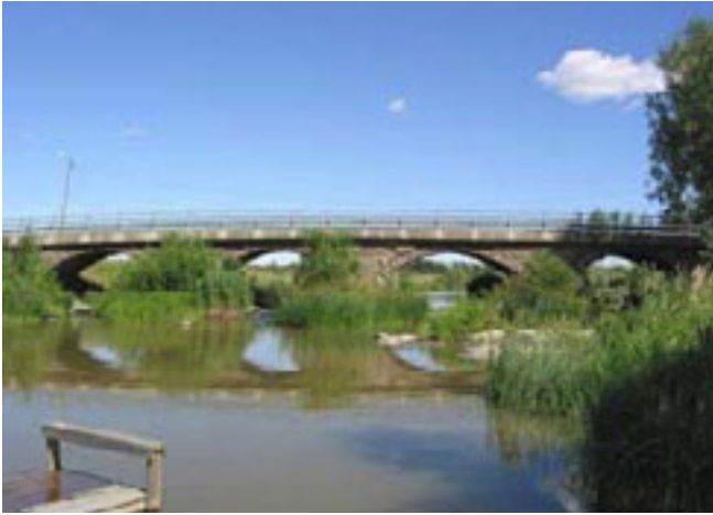
Hopenbackenin kohdalla Taasianjoen ylittää neliaukkoinen kivihoivisilta.
