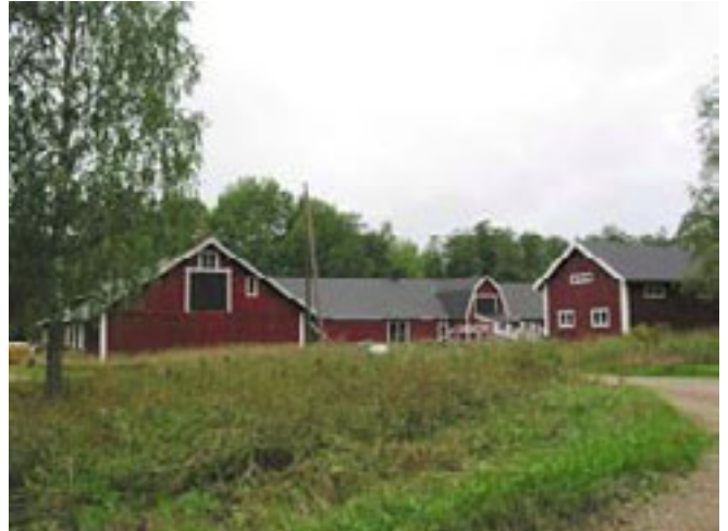
Taloussrakennukset ja työväen asuinrakennukset sijaitsevat kartanon päärakennuksen pohjoispuolella.
