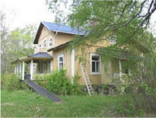
Veckasia ympäröi suuri puutarha. Päärakennus on v:lta 1892.
