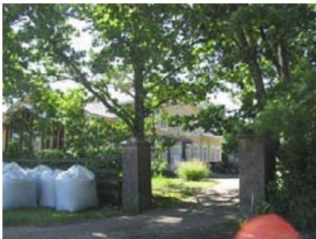
Pockar gårdin päärakennusta korjataan kesällä 2006.
