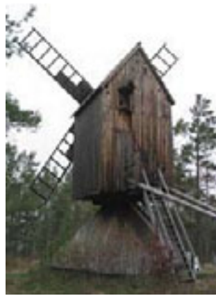
Maakunnassa harvinainen tuulimylly sijaitsee kartanon länsipuolella olevalla korkealla mäellä.
