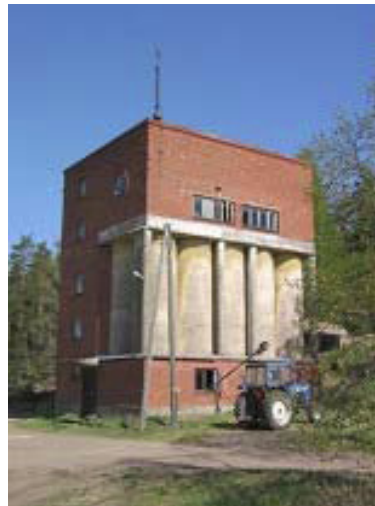
Funkis-tyylinen viljavarasto sijaitsee rakennuskokonaisuuden luoteisreunassa.
