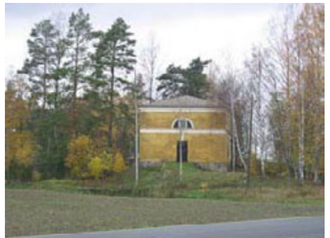
Ilolaan johtavan maantien toisella puolella sijaitseva kartanon viljamakasiini on tiettävästi C.L.Engelin suunnittelema.
