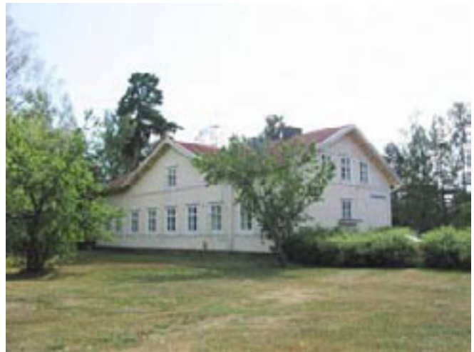
Kunnantalo sijaitsee ruukin rakennusten eteläpuolella.
