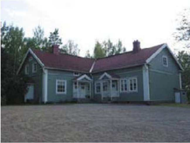
Vinkkelinmuotoinen koulurakennus sijaitsee kylän luoteisosassa.
