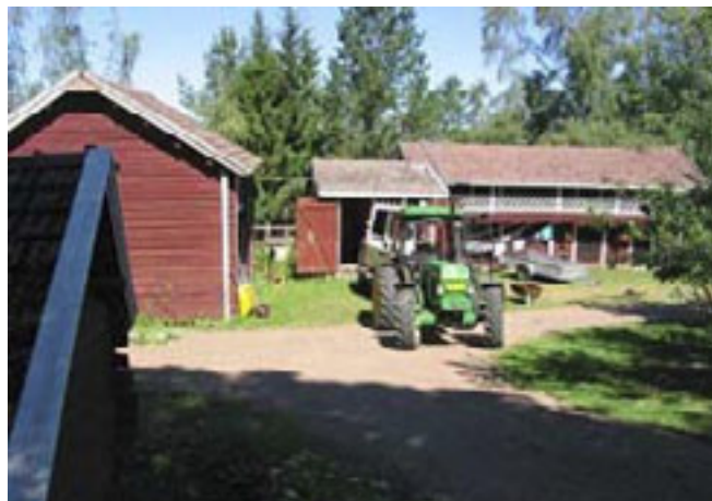
Kiilloksen pihapiirin vanhinta rakennuskantaa.
