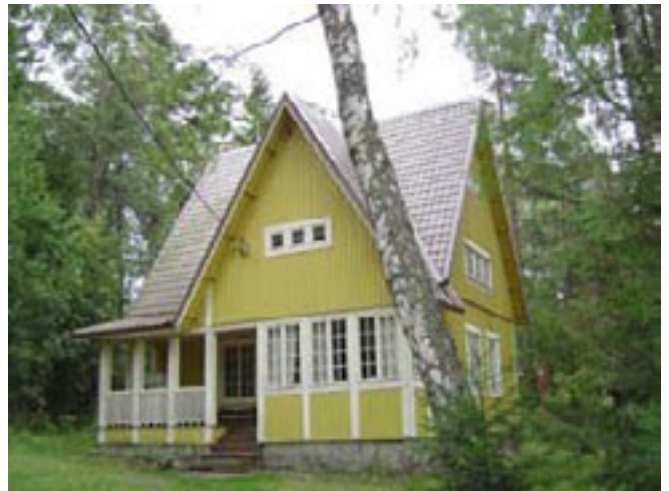
Huvila Poukama on rakennusmestari Oskari Vilamon 1905-10 suunnittelema ja rakentama.
