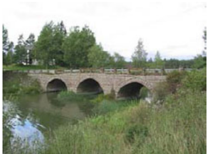
Koskenkylänjoen ylittävä kolmiaukkoinen kiviholvisilta 1900-luvun alusta.
