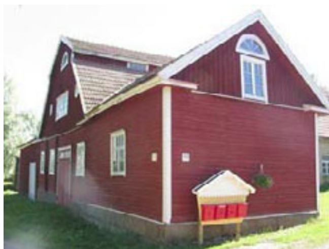
Ylä-Sihvolan säterikattoinen navettarakennus on osin hirsirakenteinen.
