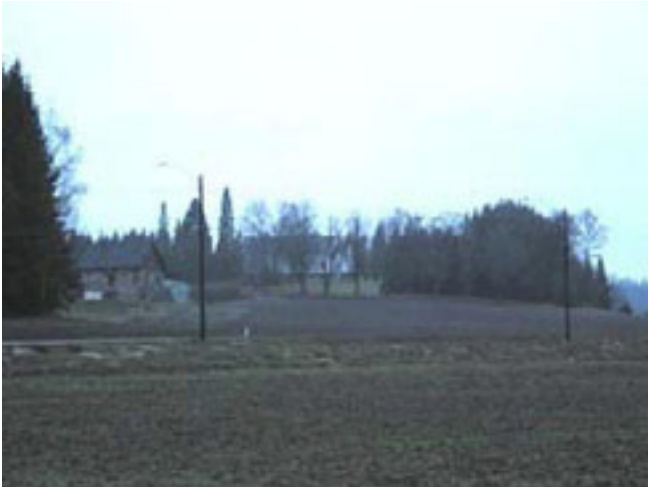
Norrkullan vanha rälssisäteri. Tilan nykyinen rakennuskanta on 1800-luvulta.
