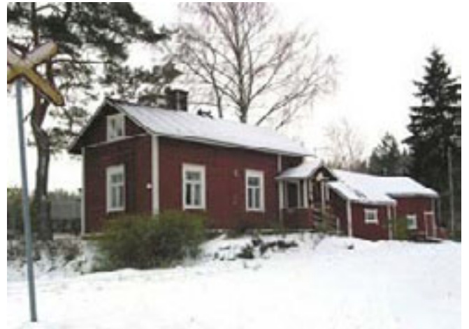
Vanha asemarakennus Yli-Vekkoskella.
