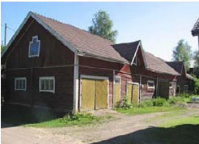
Toimelan hirsirakenteinen karjarakennus on poistettu käytöstä.
