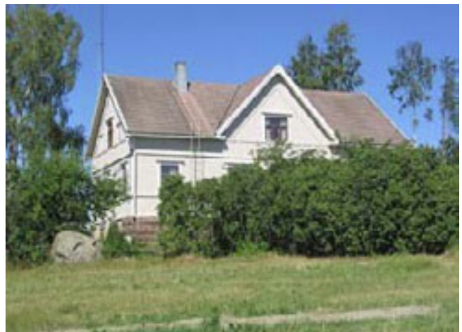
Hirsirakenteinen Simosasin päärakennus vuodelta 1927 sijaitsee Lassasbackenilla, Ruotsinpyhtäälle johtavan maantien varressa.
