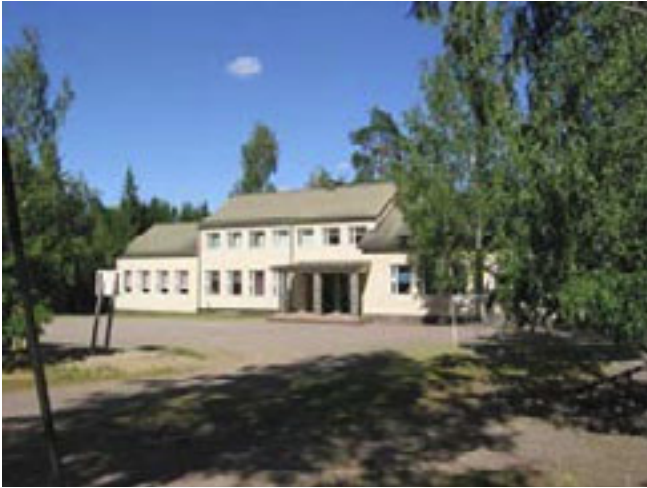
1950-luvulla valmistunut koulurakennus kylätien varressa.
