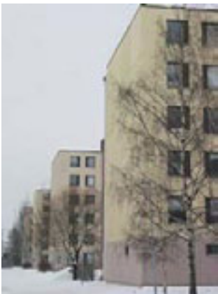
Gammelbackan elementtirakenteisia kerrostaloja 1970-luvun puolivälistä.
