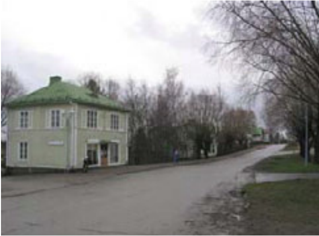
Ison Kylätien rakennuksia 1900-luvun alusta.
