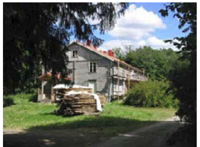
Myrskylän kartanon 1700-luvulla rakennettua päärakennusta kunnostetaan parhaillaan.
