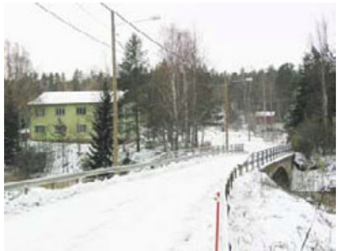
Tjusterbyssa Mustijoen ylittää betonisilta, joka on rakennettu vuonna 1915.
