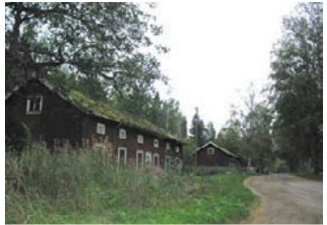
Työväen asuinrakennuksia vastapäätä sijaitsevat useammalle perheelle tarkoitetut varasto- ym. ulkorakennukset.
