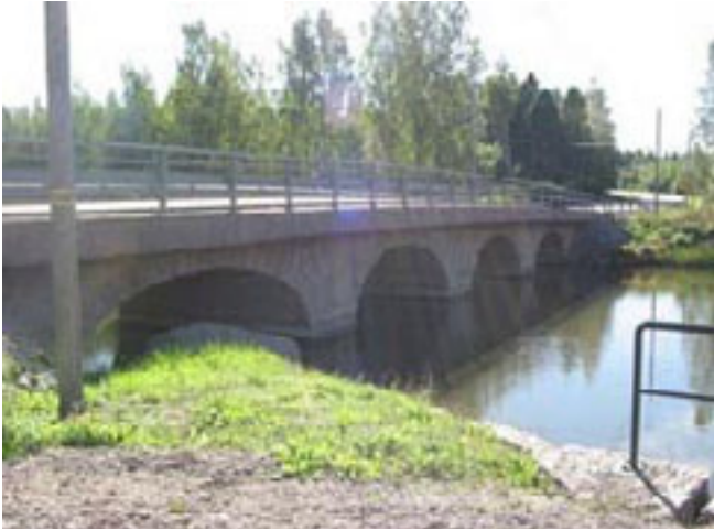
Neliauukkoinen kiviholvisilta ylittää joen Kuuskoskella.
