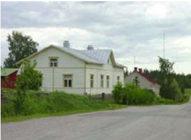
Husulan ja Kylänpään päärakennukset vanhan tien varrella.
