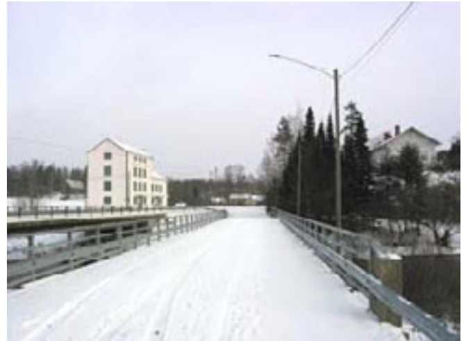
Myllyrakennus (1934) sijaitsee paikassa jossa Mustijoki ja Suuren rantatien linjaus yhtyvät.
