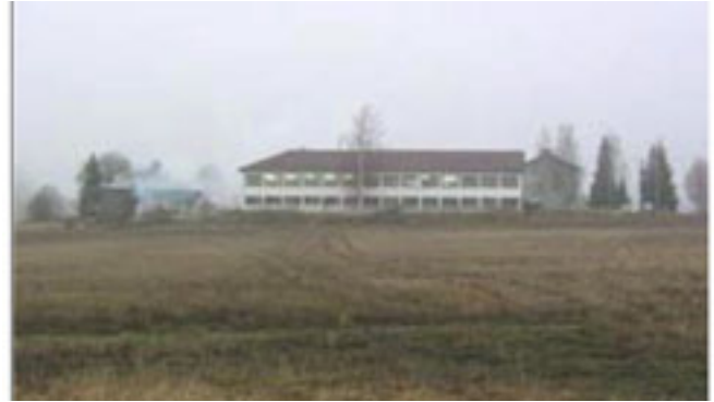
Teollisuusrakennus keskellä kylää.
