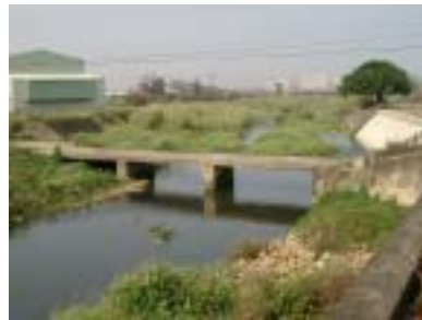
5-33 跨越田心村與溪海村的小橋
