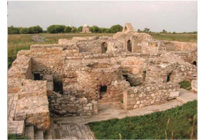
26.2.66. Белая палата. Вид со стороны служебной части здания
