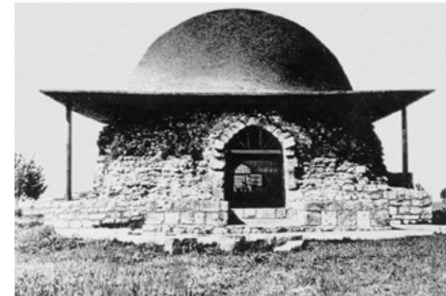
26.4.16. Монастырский погреб до (вверху) и после (внизу) консервационно-реставрационных работ
