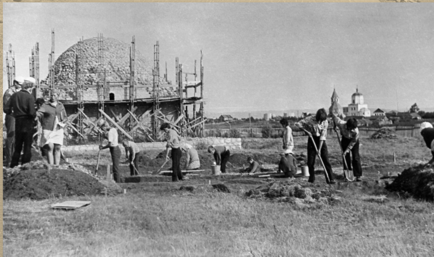
Реставрационные работы на Ханской усыпальнице и раскопки рядом с ней в 1973 г.
