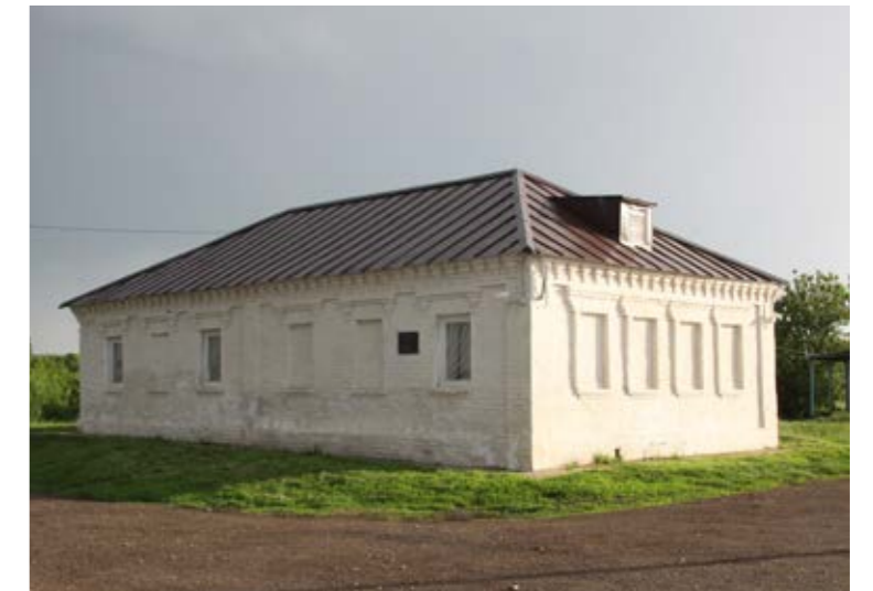
26.5.16. Здание фондохранилища БГИАМЗ
