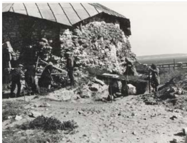
26.4.14. Расчистка восточной стороны Северного мавзолея
