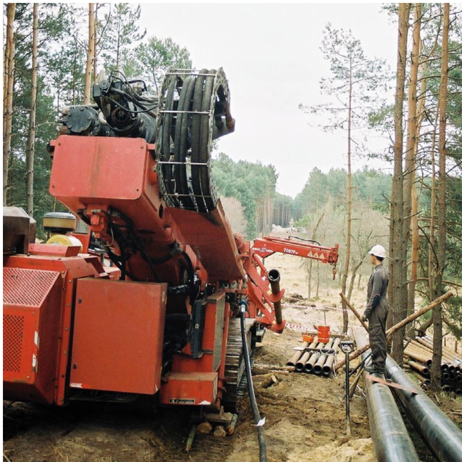
Wykonywanie przewiertu na trasie gazociągu w rejonie OC KRNiGZ Lubiatów
