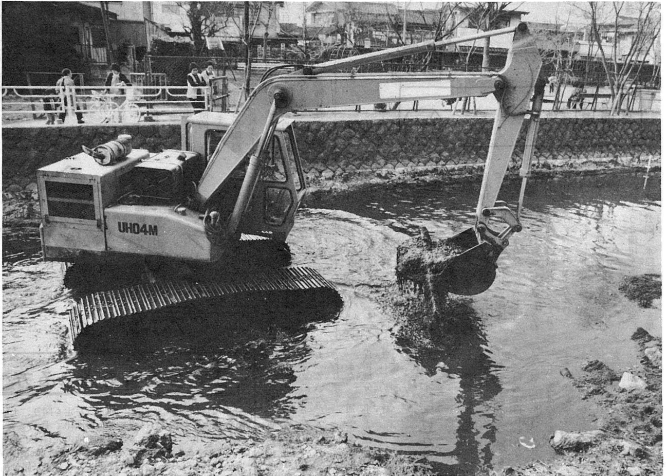
写真は、巴波川のしゅんせつ工事
