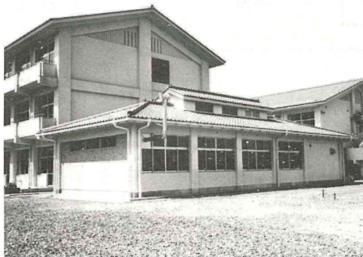
完成した第三小給食室
