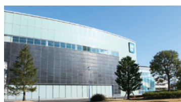
壁一面に設置された大型ソーラーパネル
