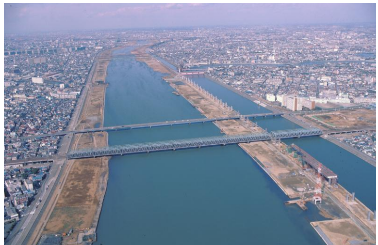
1985 (昭和 60) 年当時の荒川放水路 (東京都生活文化局)
