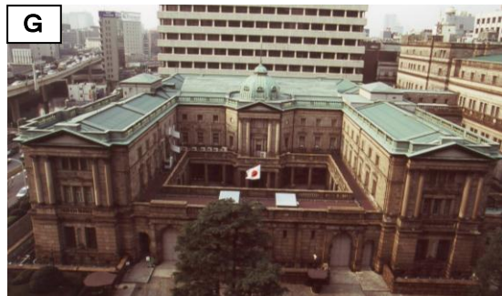
日本銀行本店（中央区日本橋本石町） （日本銀行提供）
