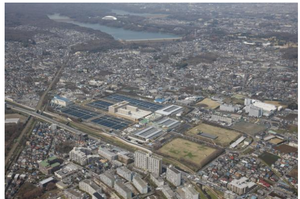
東村山浄水場（東村山市） （東京都水道局）
