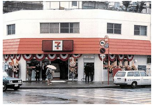
コンビニエンスストア1号店（江東区豊洲） （セブン-イレブン・ジャパン提供）
