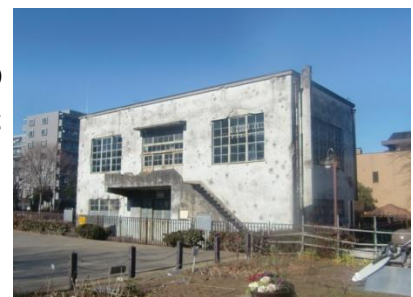
日立航空機組立工場の変電所（東大和市桜が丘）壁には機銃から撃たれた弾痕が現在も残っている。
