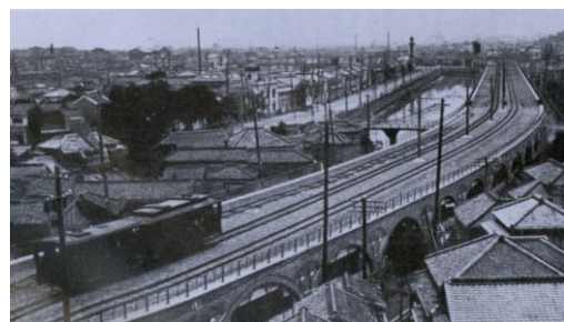
建設の進む東海道線
