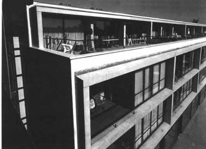
Het nieuwe centrum van bovenaf gezien FOTO GEMEENTE MAASTRICHT
