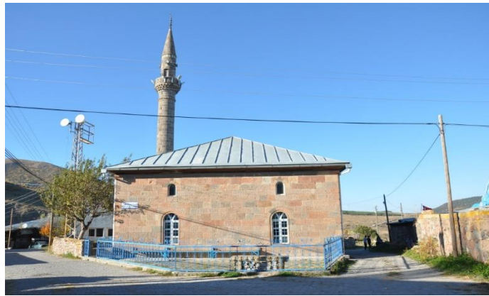
Foto. 4- Gönülaçan (Şuvaskal) Camii.
