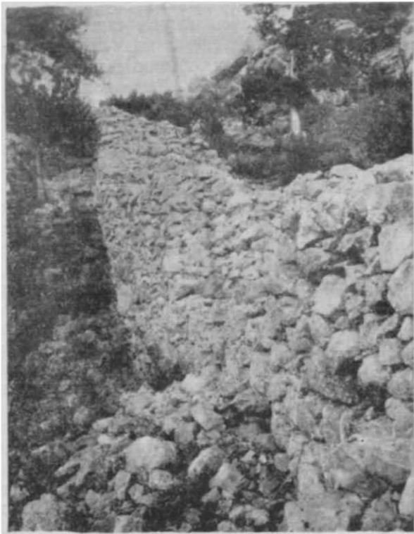
Рис. 1. Северная оборонительная стена на горе Кошка.
