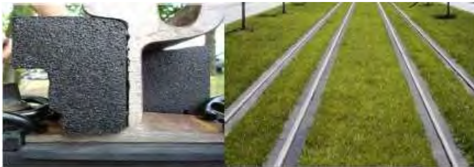
图 5.3-1 减振降噪材料包裹结构
