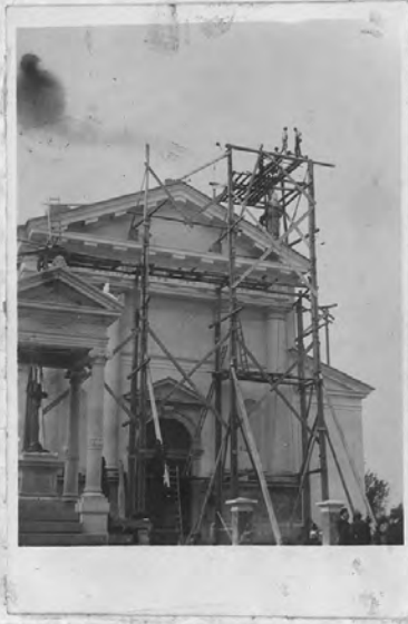
Sistemazione della Facciata della chiesa di Preganziol
