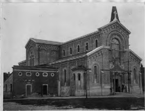
Chiesa di Veduggio in via di ultimazione.
