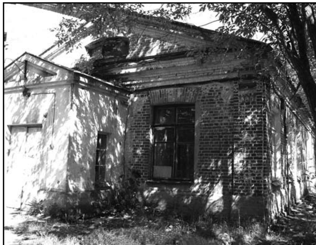
Будівля № 348 ШКЗ «Зірка», 2007 р.
