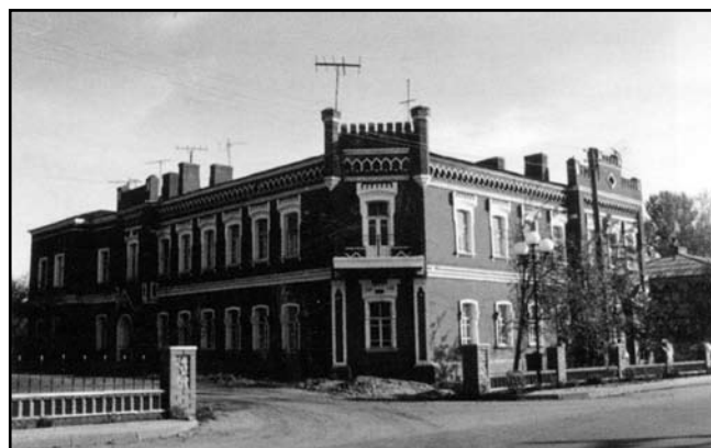
Рис. 4. Дом управляющего Глушковской суконной фабрики (в н. в. жилой дом), 2008, фото автора
