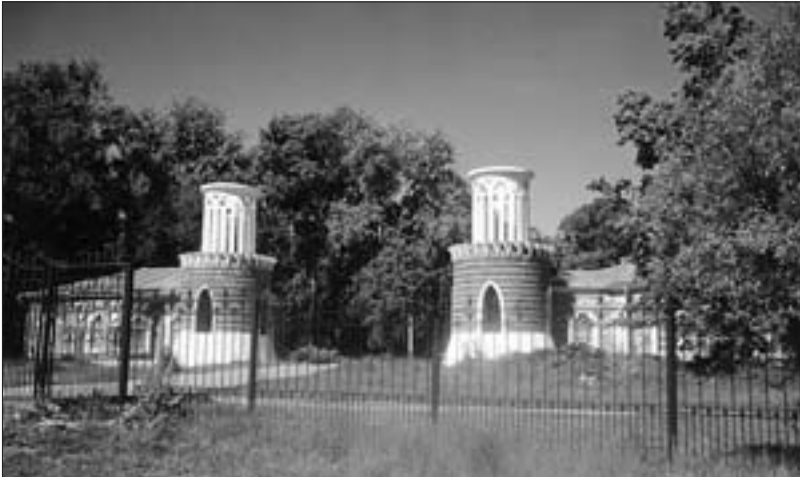
Постройки при въезде в усадьбу в Воронцове недавно отреставрированы. Сейчас это часть Москвы
