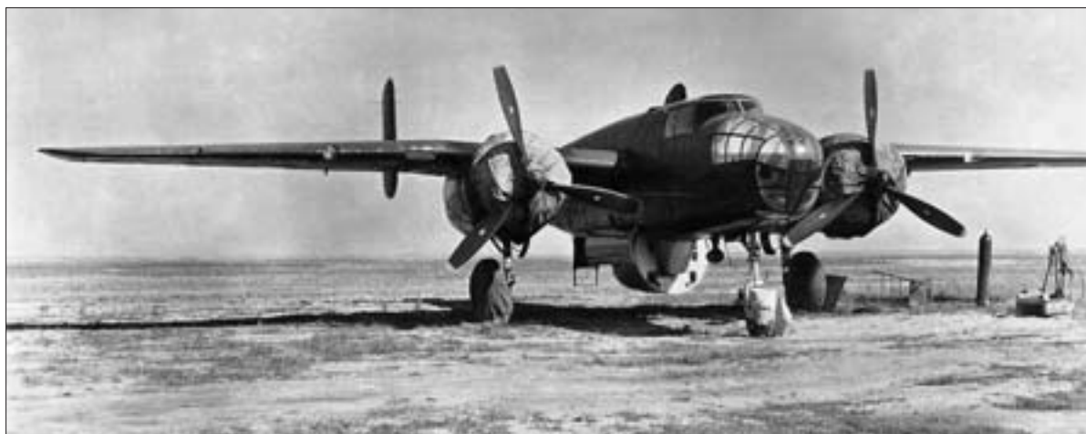
В-25 с подвешенной отделяемой кабиной самолета «346» в ЛИИ
