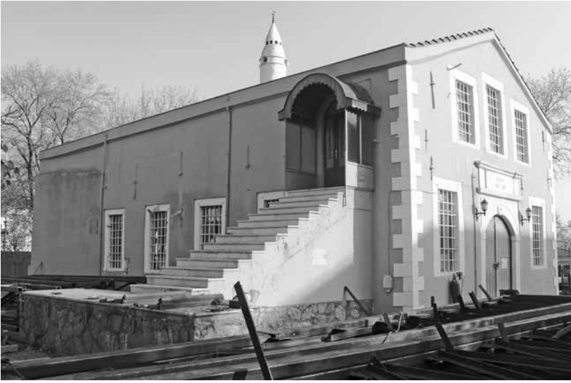
Res. 13: Yapının kuzeybatı yan cephesi ve merdiven (N. Özköylü, 2016).
