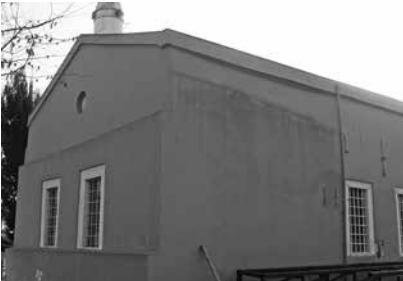
Res. 18: Yapının kuzeydoğu arka cephesindeki yuvarlak pencere (N. Özköylü, 2016).
