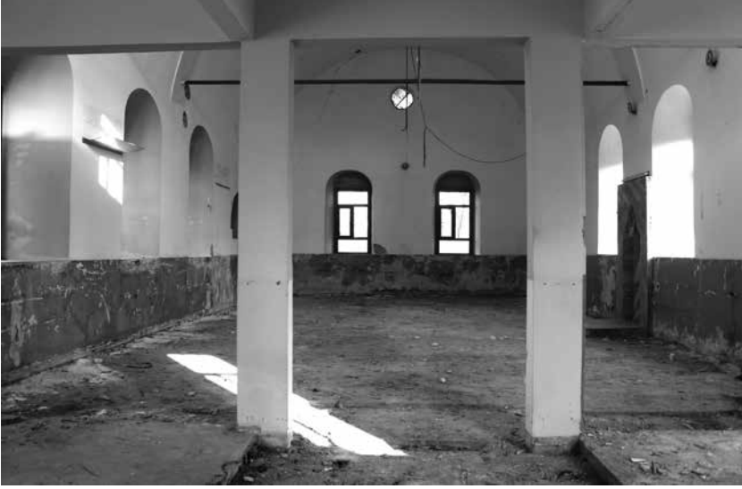
Res. 10: Apsisin yer aldığı kuzeydoğu kısmının iç mekan görüntüsü (N. Özköylü, 2016).
