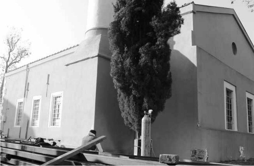
Res. 12: Yapının kuzeydoğu arka cephesi ve iptal edilen apsis kısmı (N. Özköylü, 2016).
