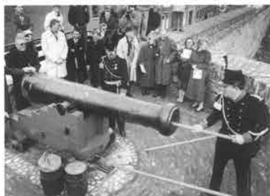
Opgelucht lachend, omdat hij toevallig aan de achterkant van de kanonsloop is gaan staan, kijkt wethouder Corten toe hoe het kanon van kruit wordt voorzien voor een daverend schot als teken dat de restauratie van de walmuur aan de Nieuwenhofstraat grotendeels is voltooid.
