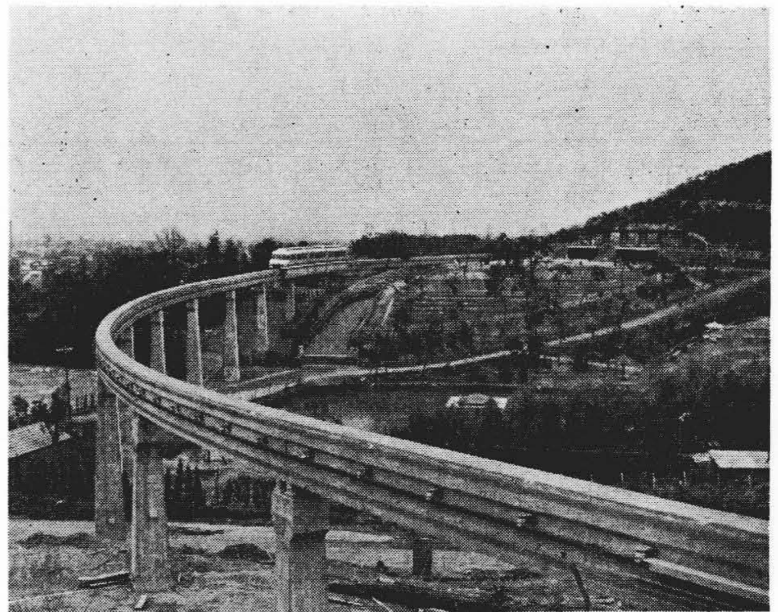
第 44 図 軌道完成状況
