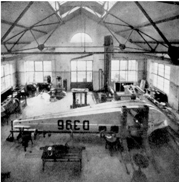
Die „Komet II“, Werknummer 52, fand trotz aller Bemühungen keinen Käufer und verblieb im sog. „DMB-Vorrat“ – eine vornehme Umschreibung für die Halde der Ladenhüter. Flügel und Leitwerk wurden vermutlich 1926/27 verschrottet, der Rumpf ging an die TH Aachen und wurde dort auf dem Festigkeitsversuchsstand für die Untersuchung von Schwingungen und Torsionsbeanspruchungen verwendet.
