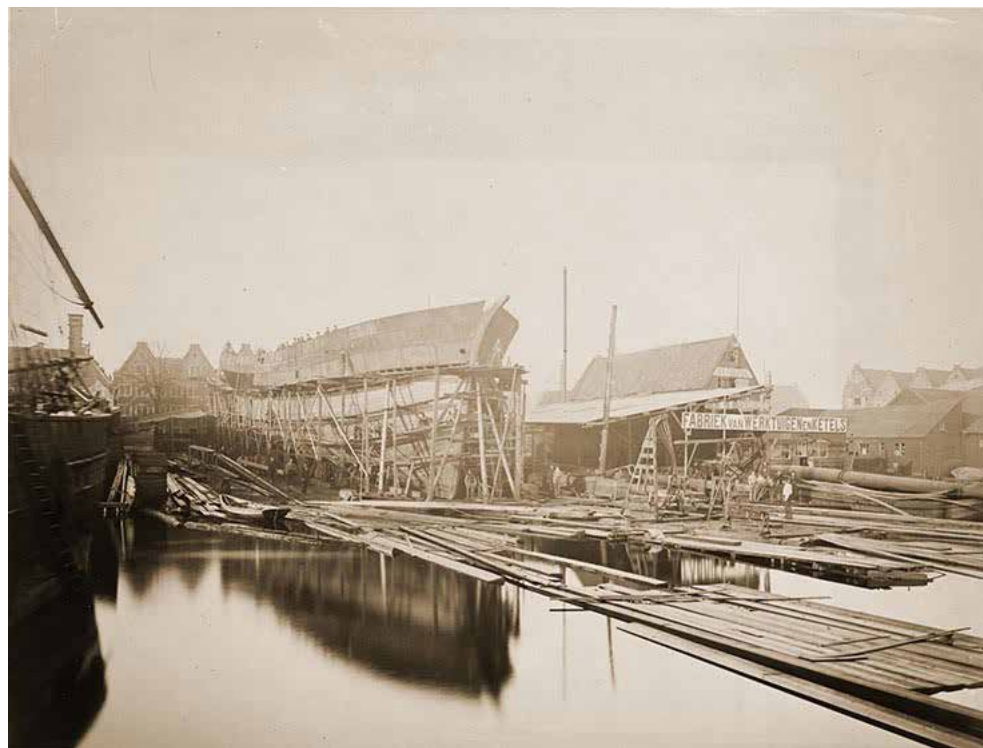
Het Compositie Clipper Barkschip “Tjerimai”, circa 1000t, in aanbouw op de werf De Nachtegaal van Jan F. Meursing, Grote Bickersstraat 78 (Atlas SAA)
