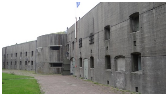
Keelzijde van de bomvrije kazerne van het Fort bij Spijkerboor, opgeleverd in 1913. (René Ros, 2014)
