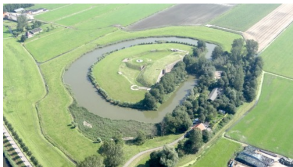
Luchtfoto van het Fort bij Spijkerboor. (René Ros, 2012)
