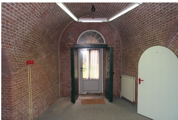
Enkele latere interieur-elementen zoals tl-verlichting, brandalarm, radiator en deuren, in de toren van het Fort aan de Uppelse Dijk. (René Ros, 2001)
