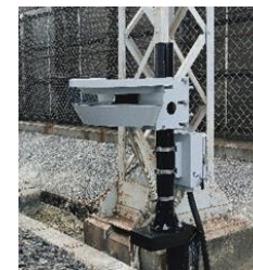
平面式踏切障害物検知装置
