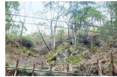
危険樹木伐採後
