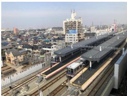
高石市内連続立体交差事業
