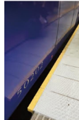
難波駅のホームに設置 しているくし形ゴム
