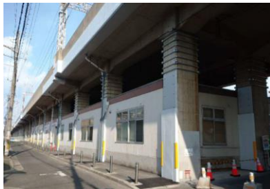
粉浜駅～住吉大社駅間 高架橋柱耐震補強工事
