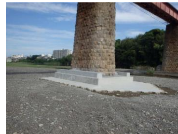
高野線紀ノ川橋梁P3橋脚
