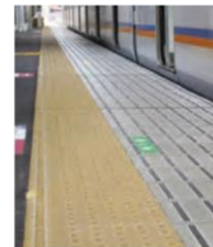
内方線付き点状ブロック
