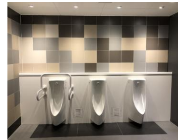
美装化完了後の駅トイレ (岸和田駅)
