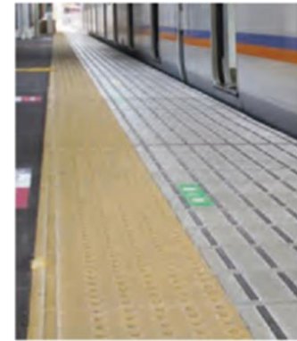
内方線付き点状ブロック
