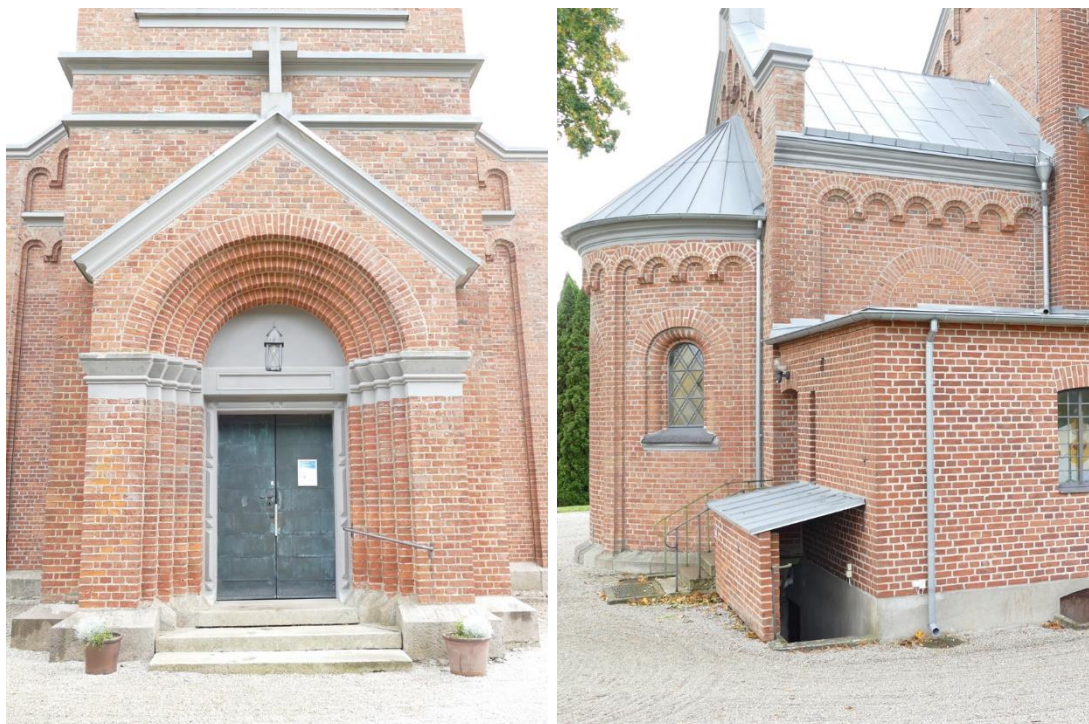
T. v: Huvudentrén i västtornet. T. h: Då sakristian byggdes 1937 sattes korets fönster och absidens entré igen och ny entré tillkom i den nya sakristian.
