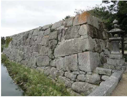
【写真 23】 切り込み接ぎに近い箇所 (本丸門跡外門西側南東隅角部)
