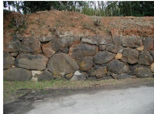
【写真6】安山岩を多用する石垣 （青貝矢倉跡南方西面）
