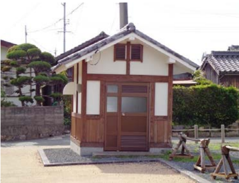
40. 消防設備用ポンプ室
