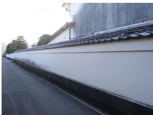
④ 伊勢屋横町（菊屋家住宅）－石垣・土塀
