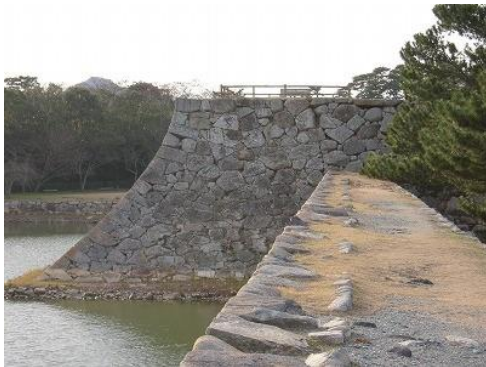
【写真 33】石垣天端の土塀基礎痕跡 (天守台東側)
