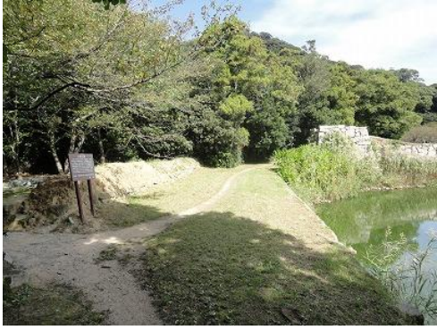
⑫ 八間矢倉跡付近より
