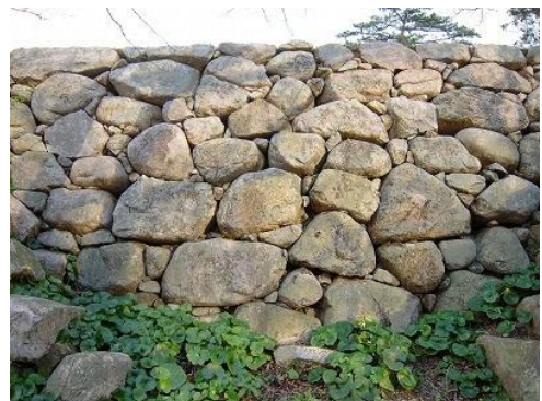
【写真 22】 野面積みに近い箇所 （本丸門跡内門北矢倉台南面）
