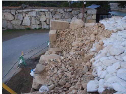
【写真 30】三階矢倉跡石垣背面の補強石
