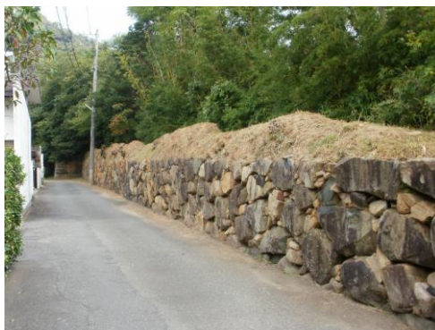
【写真41】二の丸西面石垣
