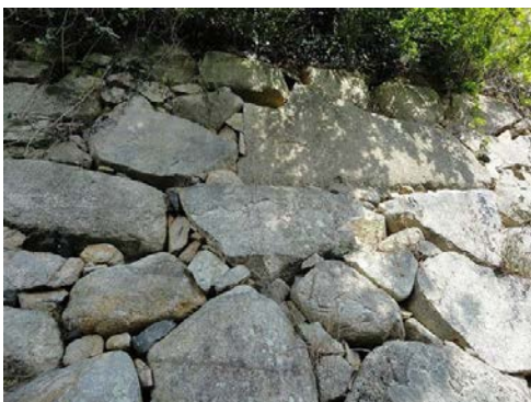
【写真 21】 打ち込み接ぎ （二の丸南門跡西方南面）
