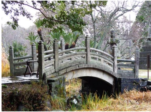
9. 市指定有形文化財明倫館遺構万歳橋
