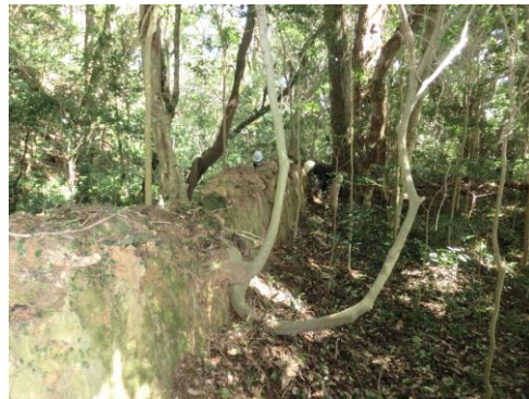
【写真 34】本丸北面の土塀痕跡
