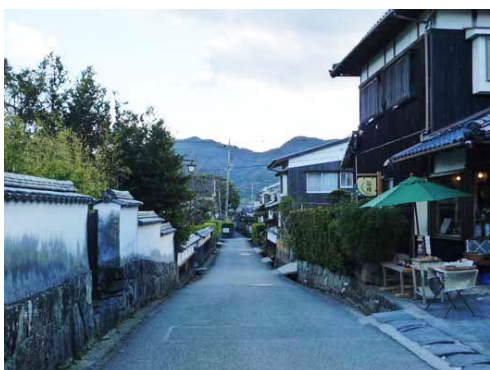
連続する土塀／電柱によって遮られた山並みのスカイライン
