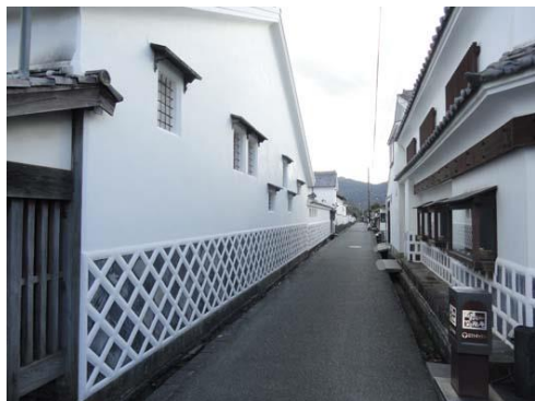
菊屋家白漆喰壁と連続する土塀
