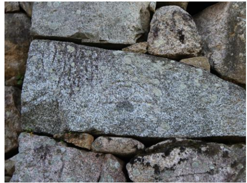
【写真 20】 刻印 （本丸門跡内門南矢倉台西方北面）
