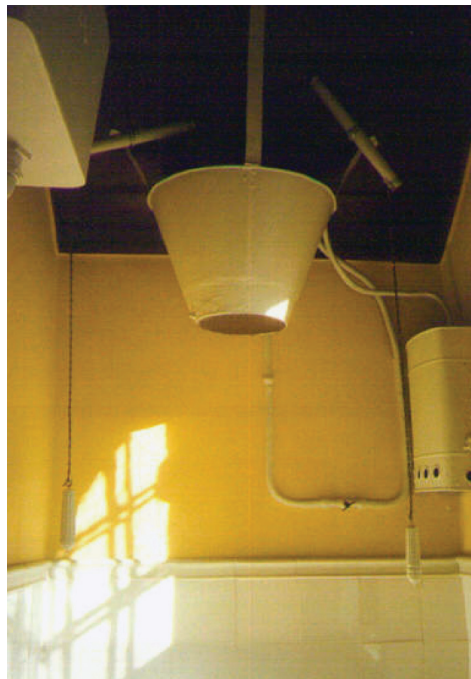
Detalhes do chuveiro com água quente, mais uma das invenções de Santos Dumont 79
