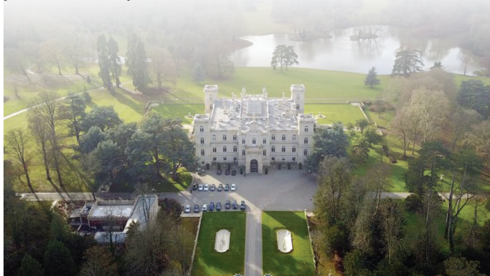
Vista aérea atual da região do Castelo de Ferrière 18
