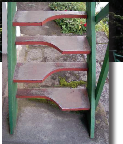
Detalhes da escada construída na parte externa da residência 78
