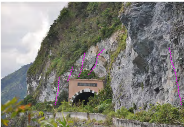
照片十三 清水隧道（已廢棄）北口與解壓節理（虛線標示於照片中位置略右側）
