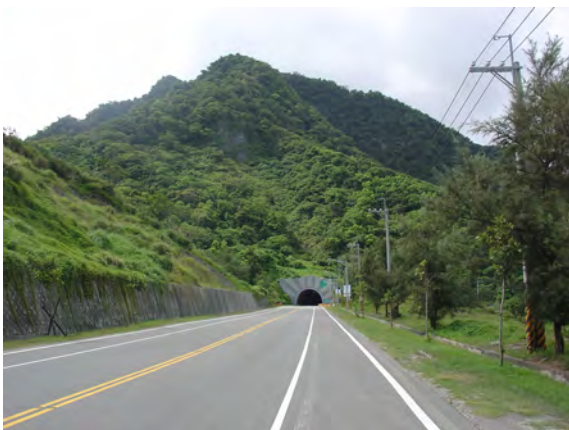
圖十一 跳浪段三號隧道南洞門口段改善前(上)、後(中、下)照片
