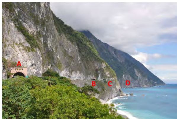
A處為匯德隧道南口、B處為已廢棄清水隧道南口，C處為1974年拓寬完成台9線路基，D處為清水斷崖
