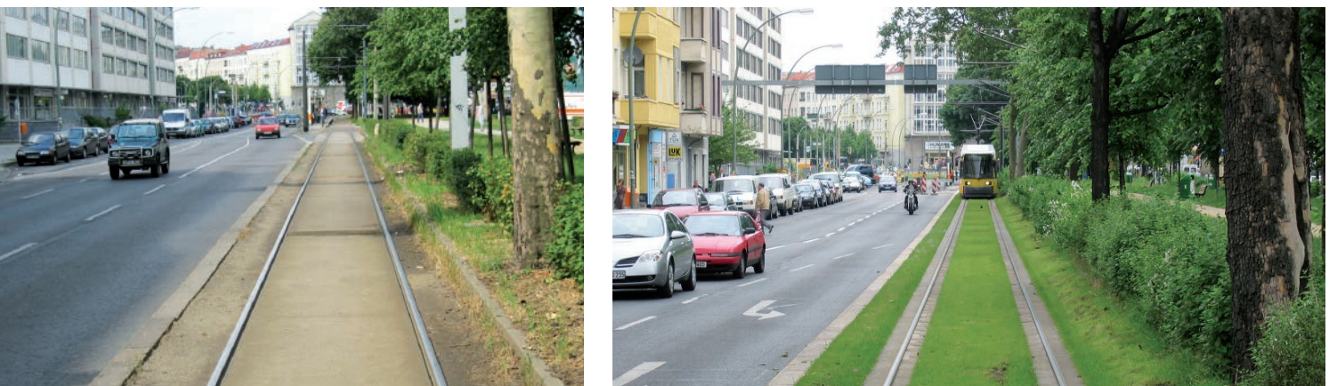
BILD 3: Erscheinungsbild der Gleise vor und nach der Begrünung [6]
