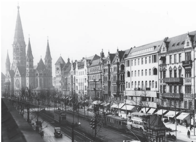
BILD 1: Rasengleise in der Taentzienstr. 1930 [1] und am Potsdamer Platz, Berlin 1933 [2]
